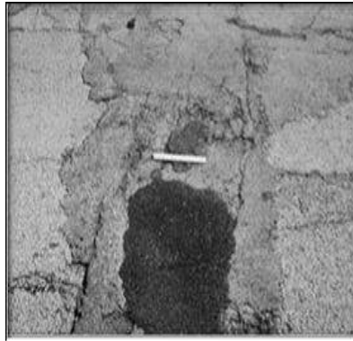
Gambar 2. 13. Tambalan ( Patching end Utiliti Cut Patching ) dengan tingkat kerusakan: (a) low ; (b) medium ; (c) hard
