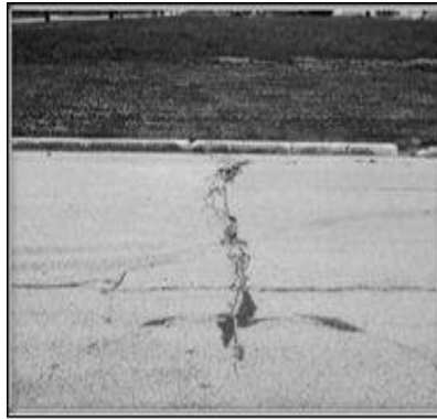
Gambar 2. 12. Retak Memanjang/Melintang ( Longitudinal/Trasverse Cracking ) dengan tingkat kerusakan: (a) low ; (b) medium ; (c) hard Sumber : ASTM D6433-07
