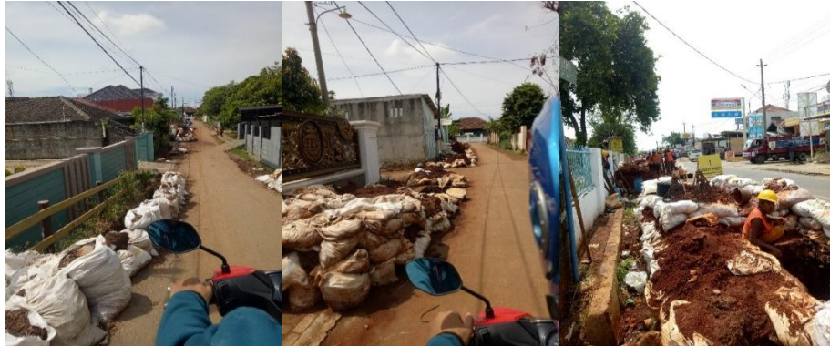
GAMBAR 3.8 PROGRESS PEMBANGUNAN SPAM DI KECAMATAN KEDATON
