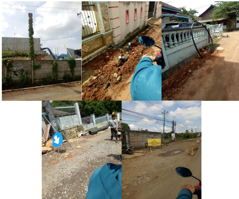
GAMBAR 3.7 PROGRESS PEMBANGUNAN SPAM DI KECAMATAN RAJABASA
