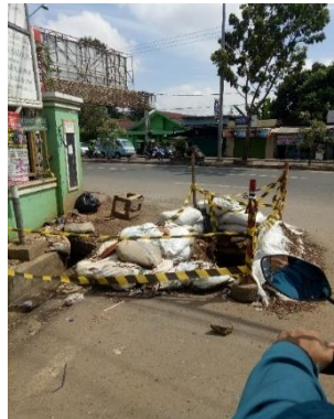
GAMBAR 3.9 PROGRESS PEMBANGUNAN SPAM DI KECAMATAN LABUHAN RATU
