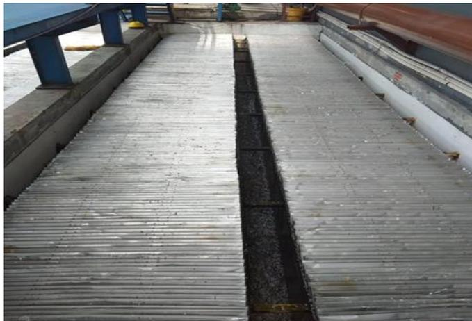
**Gambar 3.10.** Bak Sedimentasi dengan *Plat Settler* [32]
