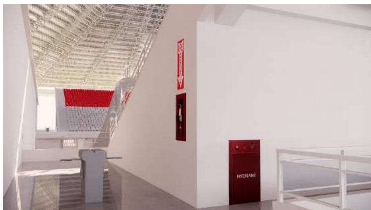
Gambar 59. Peletakkan Box Hydrant dan Fire Extinguisher
