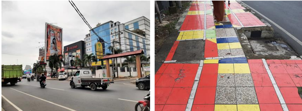
Gambar 27. Kondisi Sarana Tapak
