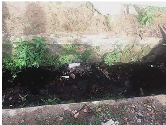
Gambar 3.9 Saluran Air/Drainase di Sekitar Tapak
