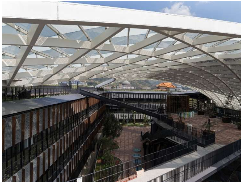
Gambar 2.2. Ruang dalam Gedung Central Taiwan Innovation Campus MOEA .
