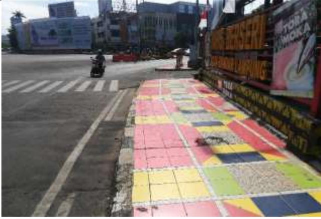
Dengan lebar 2,5 kondisi jalur pejalan kaki tanpa ada pembatas dengan jalur kendaraan bermotor, bahan yang digunakan yaitu keramik yang licin tanpa adanya jalur difabel dengan kondisi iklim yang panas tanpa adanya penutup seperti pergola dan vegetasi.
