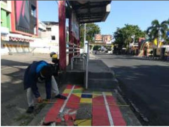
Dengan lebar 2,5 kondisi jalur pejalan kaki tanpa ada pembatas dengan jalur kendaraan bermotor, bahan yang digunakan yaitu keramik yang licin tanpa adanya jalur difabel dengan kondisi iklim yang panas tanpa adanya penutup seperti pergola dan vegetasi.
