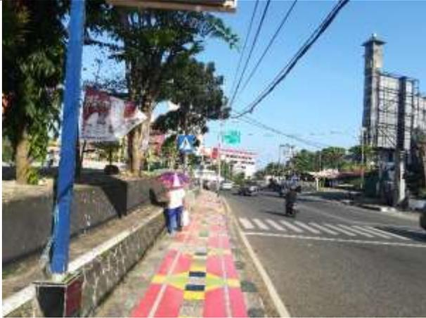
Dengan lebar 2,5 kondisi jalur pejalan kaki tanpa ada pembatas dengan jalur kendaraan bermotor, bahan yang digunakan yaitu keramik yang licin tanpa adanya jalur difabel dengan kondisi iklim yang panas tanpa adanya penutup seperti pergola dan vegetasi Terbukti pada gambar pengguna jalur pejalan kaki menggunakan payung sebagai alternative persoalan tersebut.
