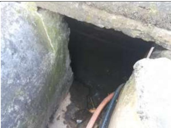
Kondisi drainase tertutup dengan lebar 1,6 meter tinggi 1,5 meter cukup lancer air yang mengalir kadang terdapat sampah yang ikut hanyut pada drainase.
