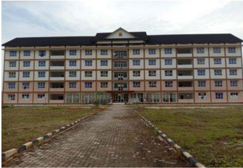
Gambar 3.2 Gedung Asrama TB 4 ITERA Sumber: Dokumentasi Foto, 2020
