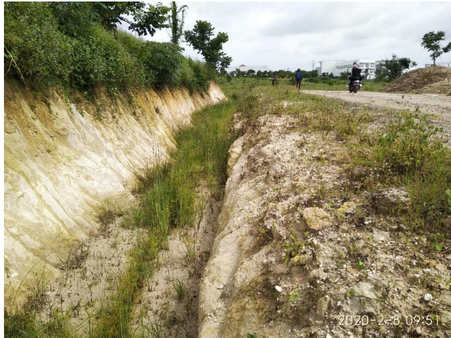
Gambar 3.2. Keadaan Existing Drainase Alami Sebelah Kiri Gedung F
