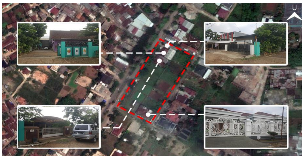
Gambar 3.9. Kondisi bangunan eksisting di sekitar tapak
