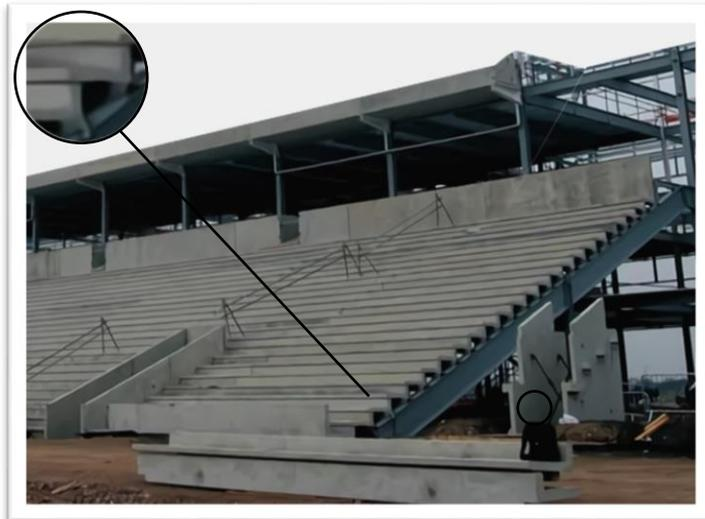
**Gambar 2.3.** Struktur tribun baja dan beton.
