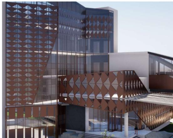
Gambar 6.9 Penggunaan material *light copper* pada fasad
