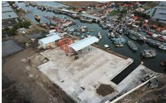
Terminal untuk kepentingan sendiri (TUKS) (Sumber gambar : google)
