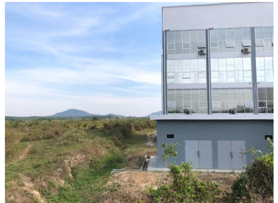
b. Gedung F
