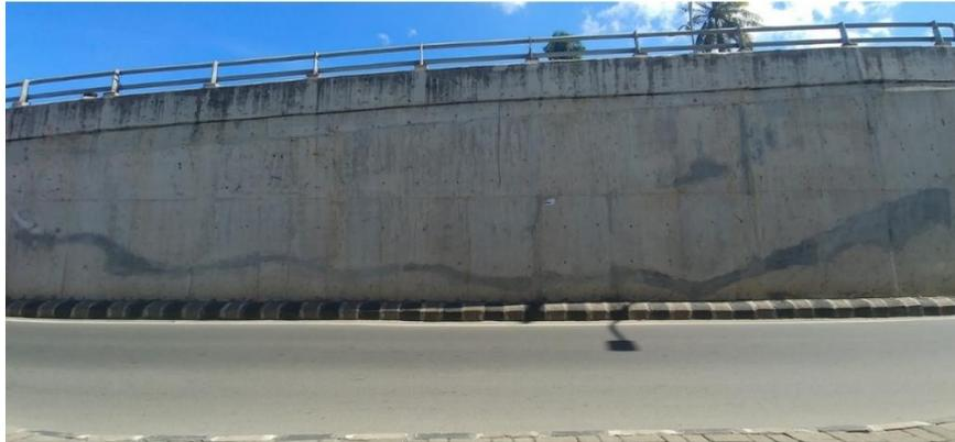
Gambar 1.1 Jembatan Layang Jalan Teuku Umar - Jalan Z.A. Pagar Alam Retak
